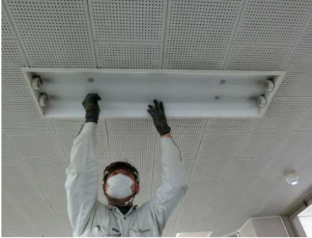
①蛍光管をはずす。
